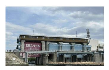
先週、大阪の「造幣局 桜の通り抜け」を横目に見ながら、小型船舶で通過した大阪の毛馬閘門は、明治期の淀川改良工事に伴い 1907(明治 40)年に竣工したもので、淀川と大川の水位差(約3m)を調整する機能を有しています。約20分をかけて水位が調整されていく様を体感し閘門を通過した後に抱いた感想は、現代社会が直面している人権問題の本質と相通ずるものがあるのではないかということです。
