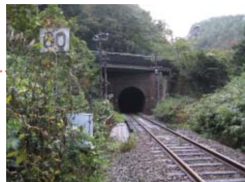
多くの朝鮮人が工事に従事した城崎芦谷トンネル
